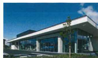
2. 結城信用金庫小山城南支店新築
